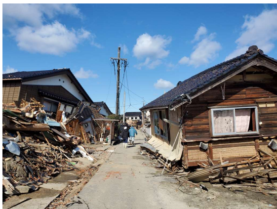
能登半島地震で倒壊した木造住宅（2024年2月 入江撮影）
